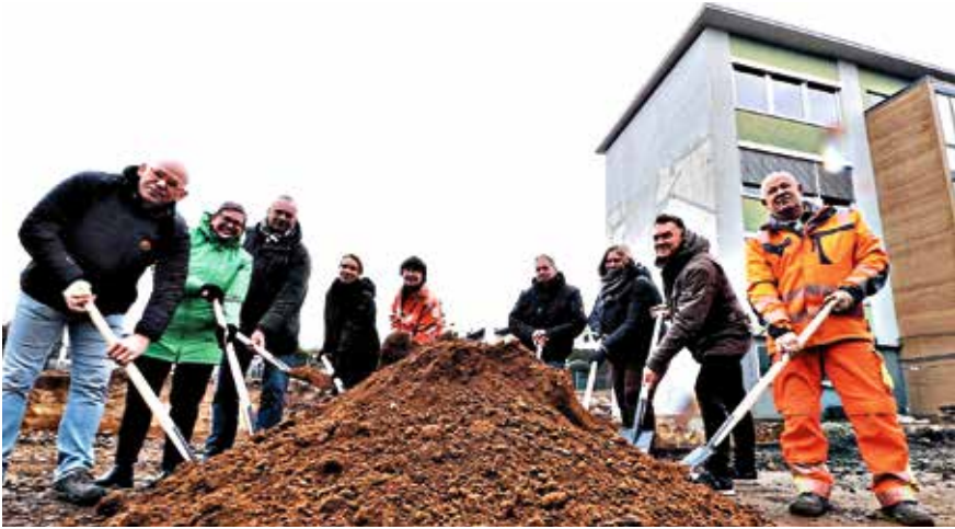
Im Hintergrund das LLG-Haus B, an das der Neubau mit einem Stockwerk niedriger angebaut wird. (Fotos: GAZ)
